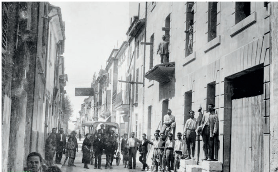
Acabat les obres de Can Corró, any 1924/1925, carrer Mercat nº 19-21
