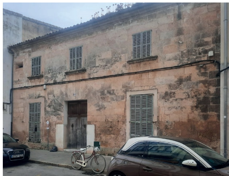
Habitatge ubicat al carrer gran nº 63, Cas Metge Corró.
